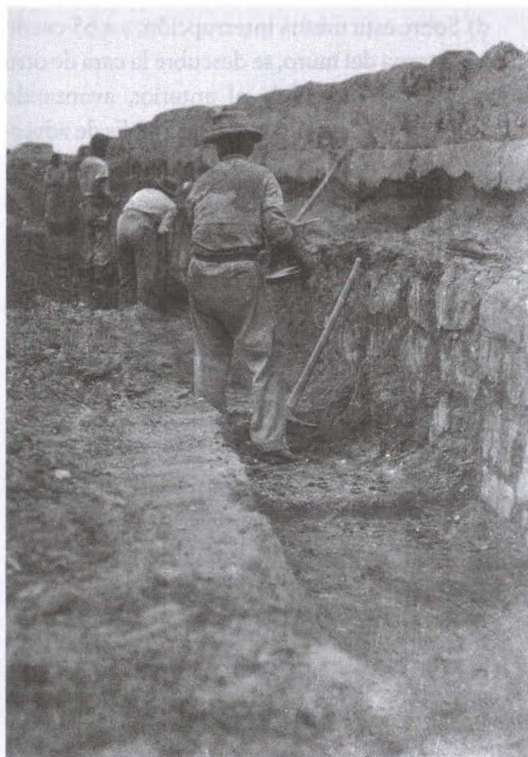
Figura 9. Pachacamac. Vista de los trabajos de excavación al pie norte del muro que corre de Este a Oeste, al costado sur de la Laguna de Los Patos. Noviembre de 1940, [X/B19/P11/F12/406].
