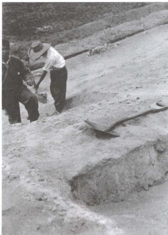
Figura 118. Vista parcial del muro A, cateo 1, momentos antes de su descubrimiento, 15 de octubre de 1941. [X/B19/P11/F7/191].
